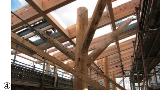
丸太の方杖付柱と格子梁が支える保育室
