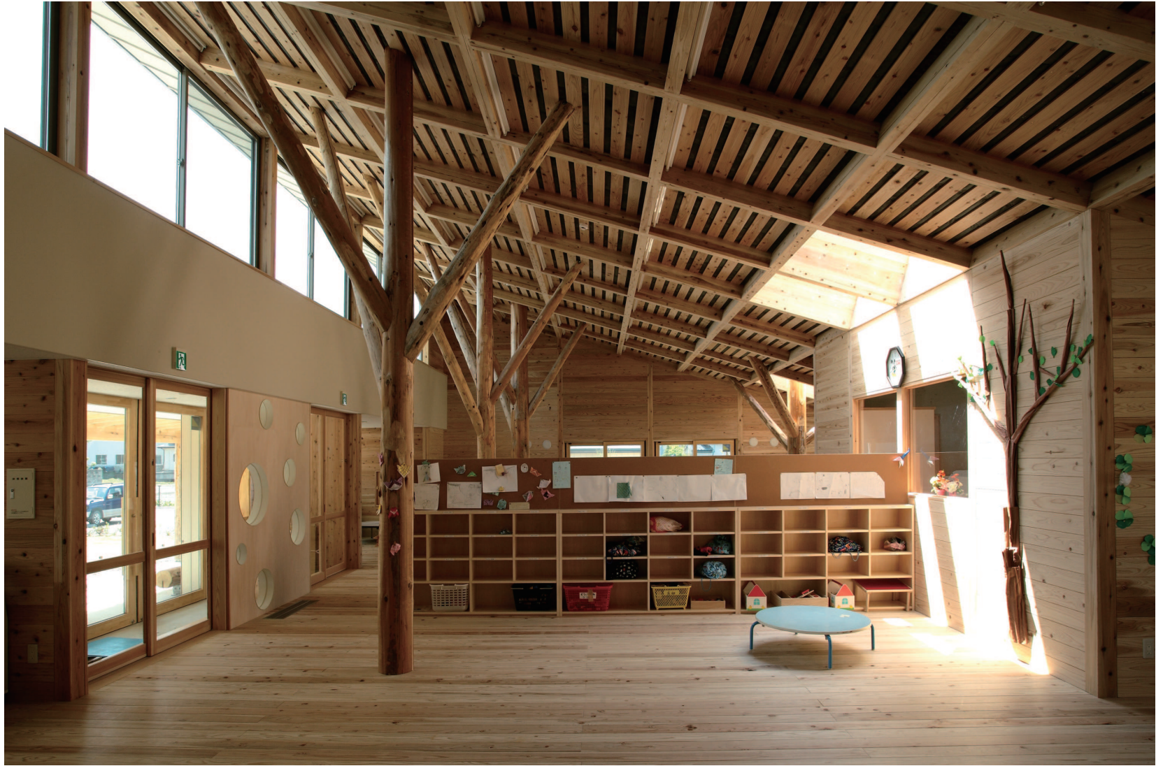
丸太の方杖付柱と格子梁が支える保育室
