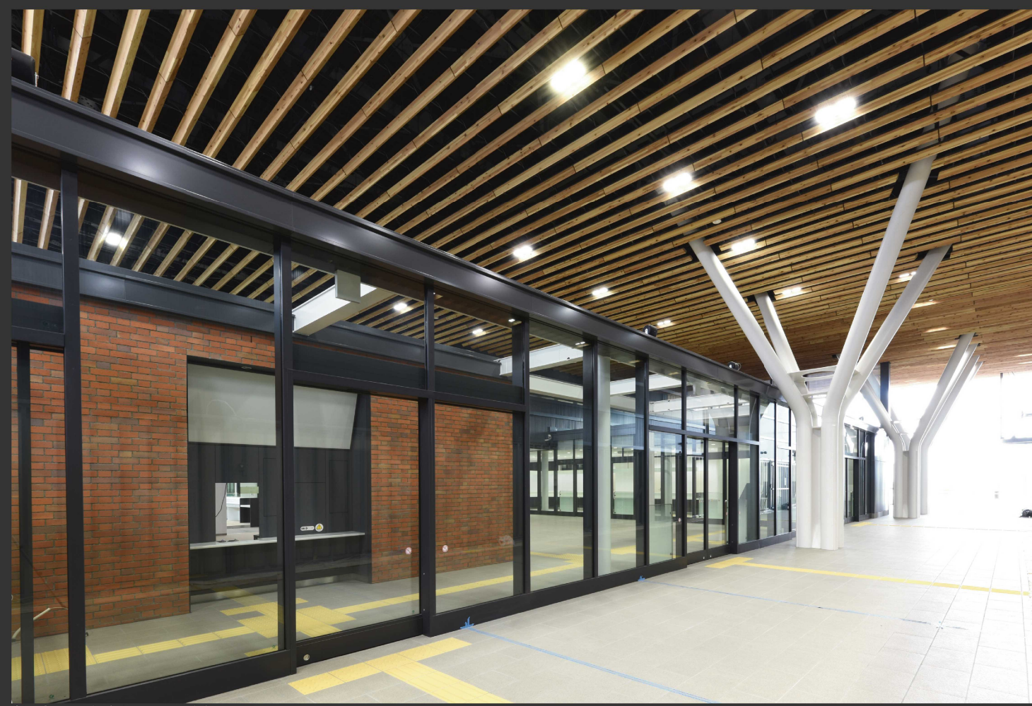
旅客通路(自由通路)より柵外コンコースを見る:
