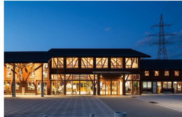
2方向トラスにより壁が不要で、内部の活動がみな透けて見える。
