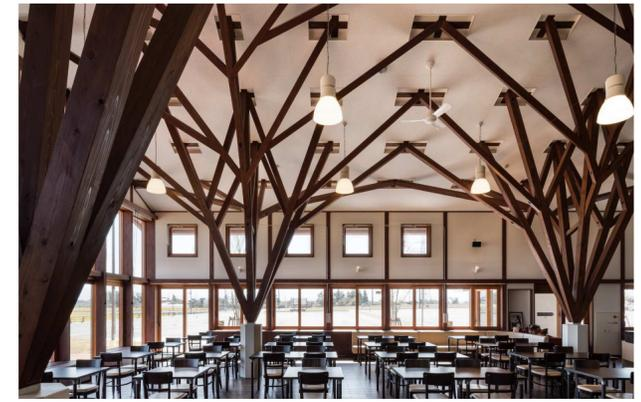
樹状トラスは6枚の平面トラスの組合せによるシンプルな構成。
