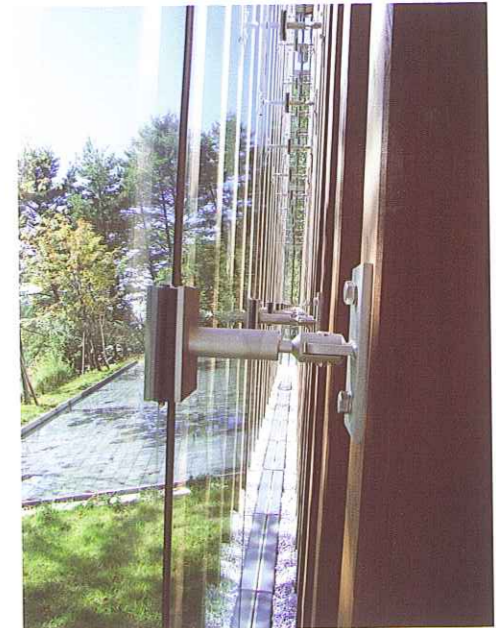
MPG工法のガラスを支える木柱
