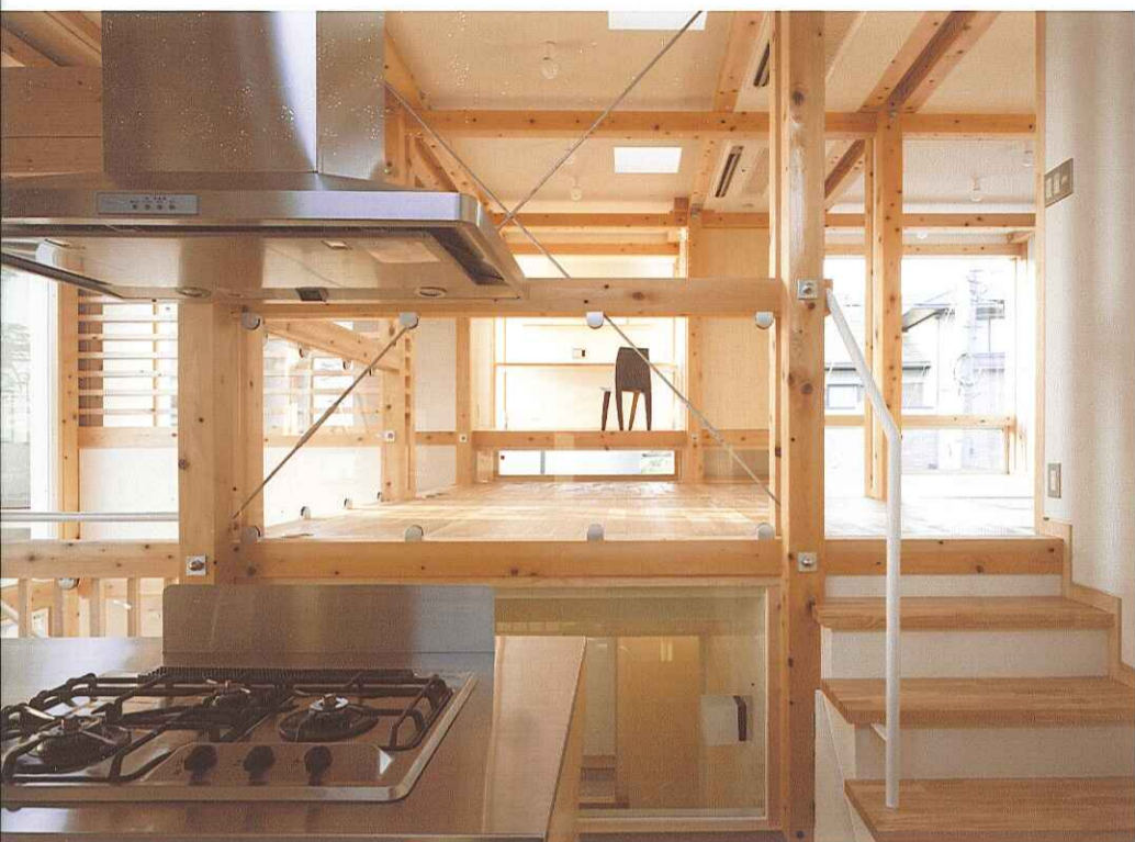
2本ペアの柱、横架材全てが120角で構成されている
