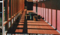
■ キーホール：廊下は新築棟にもあるものを採用している。新築の廊下から光が透る。うねる梁が天井に透らされる。
