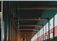
■ キーホール：廊下は新築棟にもあるものを採用している。新築の廊下から光が透る。うねる梁が天井に透らされる。
