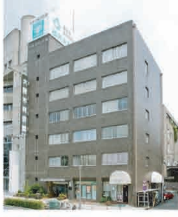
【既存建物概要】 所在：大阪府大阪市西区 規模：鉄筋コンクリート造 6階建て 外装：タイル張り
