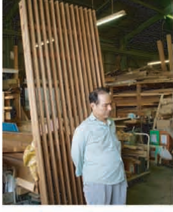
【木外壁パネルの製作】 外表面積：500㎡ 使用材積：21.5㎡ 使用材料：大阪府産検材サーモウッド 国産杉材サーモウッド 一部不燃処理加工
