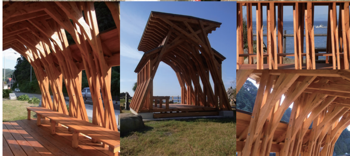
高校生案の実施設計化 曲線アーチを檜の線材で再構成。900ミリピッチで再構成アーチ(右)を配置し、その間300ミリピッチで片持ち軸組(左)を交互に挟み込みこんで波を表現した。
