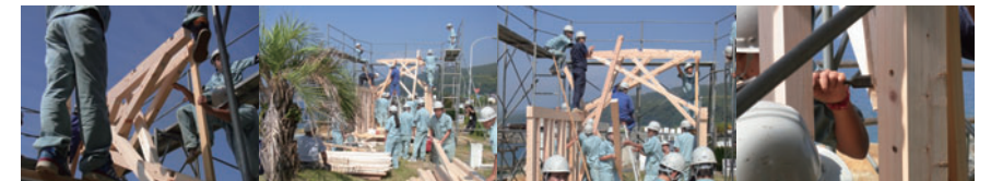
高校生案の実施設計化 曲線アーチを檜の線材で再構成。900ミリピッチで再構成アーチ(右)を配置し、その間300ミリピッチで片持ち軸組(左)を交互に挟み込みこんで波を表現した。
