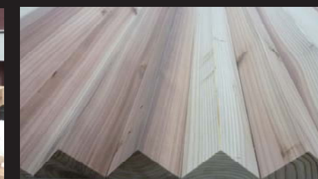
手摺 (スギ) 材を三角柱に加工し壁材に
