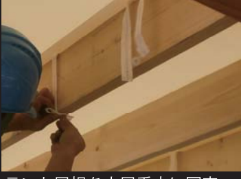
テント屋根を小屋垂木に固定
