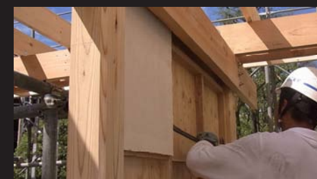
壁→手すり→床→軸組と丁寧な解体
