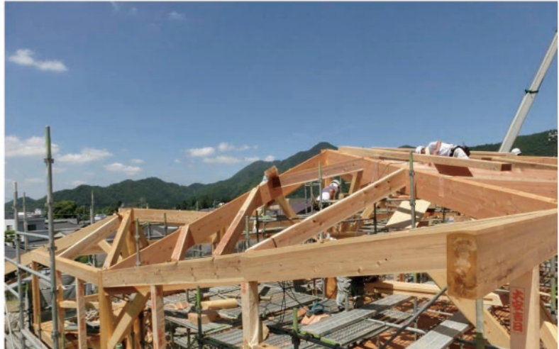
在来工法による木の枝のような架構
