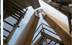
⑥ ジョイント金物による壁柱の連結
