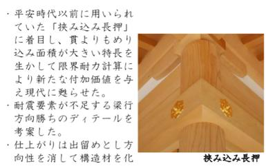
平安時代以前に用いられていた「挟み込み長押」に着目し、貫よりもめり込み面積が大きい特長を生かして限界耐力計算により新たな付加価値を与え現代に甦らせた。
