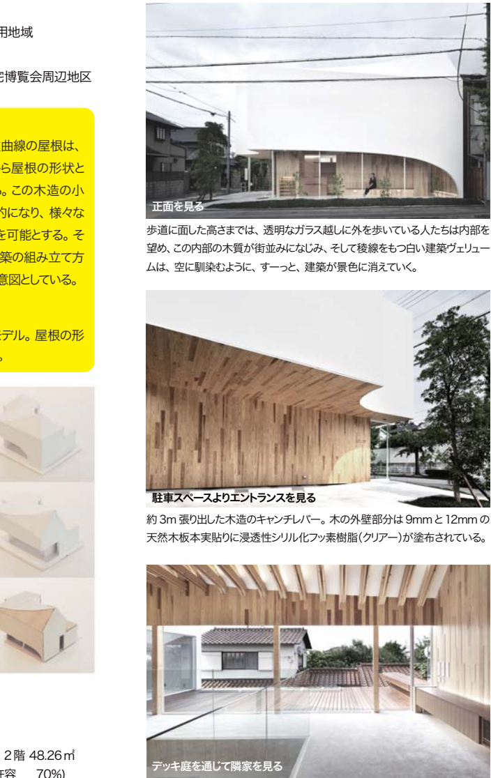
正面を見る 歩道に面した高さまでは、透明なガラス越しに外を歩いている人たちは内部を望め、この内部の木質が街並みになじみ、そして縁縁をもつ白い建築ヴォリュームは、空に馴染むように、すーっと、建築が景色に消えていく。 駐車スペースよりエントランスを見る 約 3m 張り出した木造のキャノピー。木の外壁部分は 9mm と 12mm の天然木板本実貼りに透過性シリル化フッ素樹脂（クリアー）が塗布されている。 デッキ庭を道して隣家を見る 隣家の軒先の高さにより、この建築の 1 階レベル（高さ）を決定している。隣接した建物の屋根の瓦や樹木にとつもの見方を与え、その抽象化という作業から周りの環境との間に一種の距離間を生み出している。
