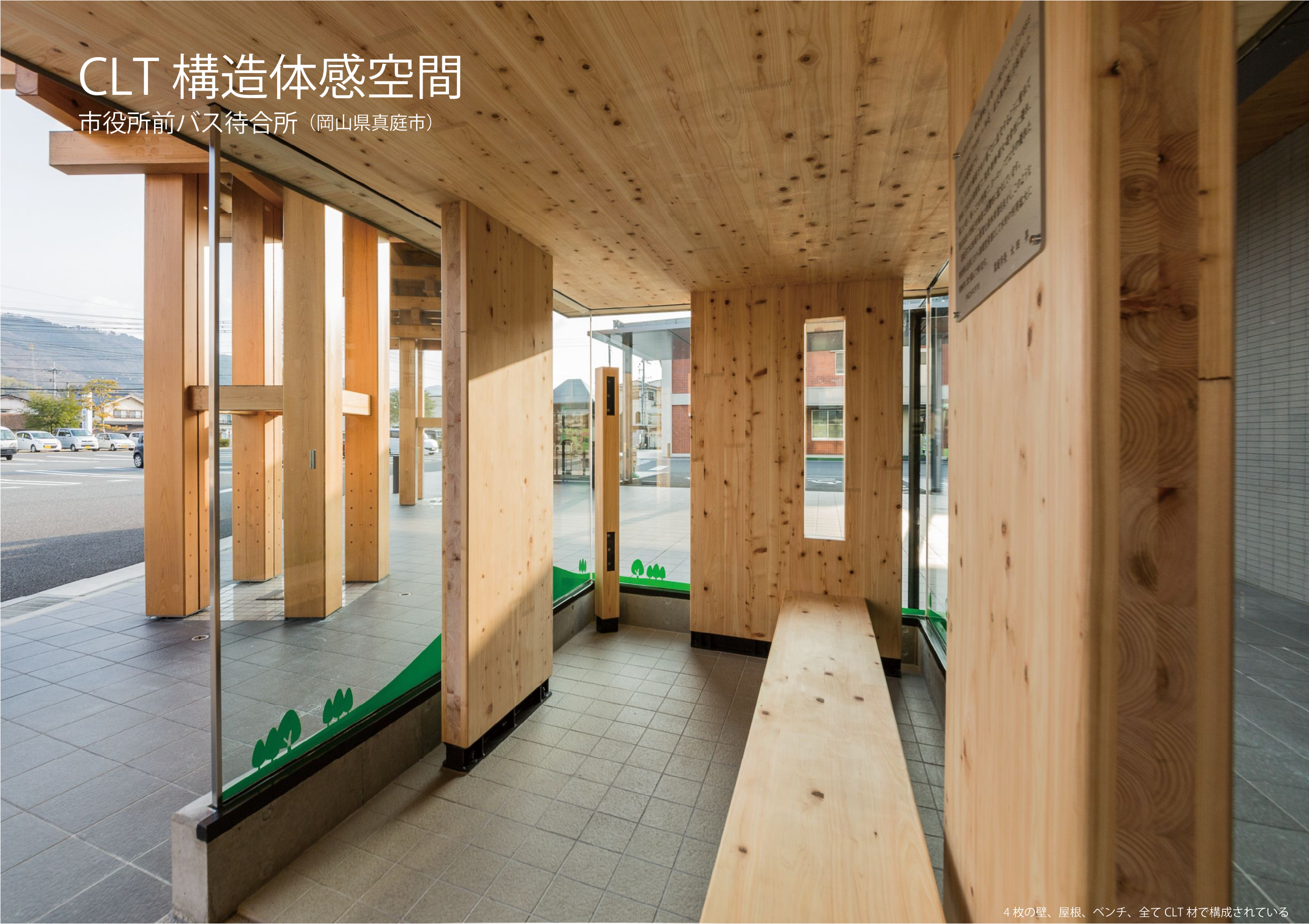
4 枚の壁、屋根、ベンチ、全て CLT 材で構成されている
