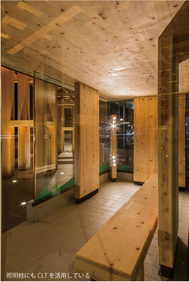
照明柱にも CLT を活用している
