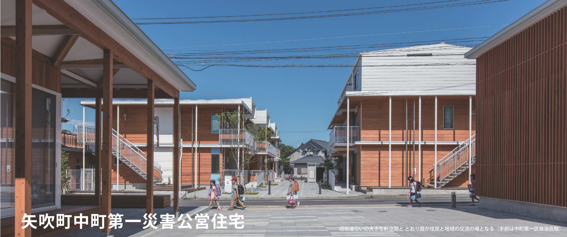
居住空間のよりどころとなる集成材厚板パネルの壁柱
