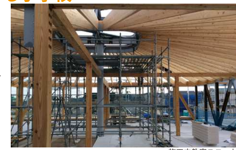
施工中教室ユニット
