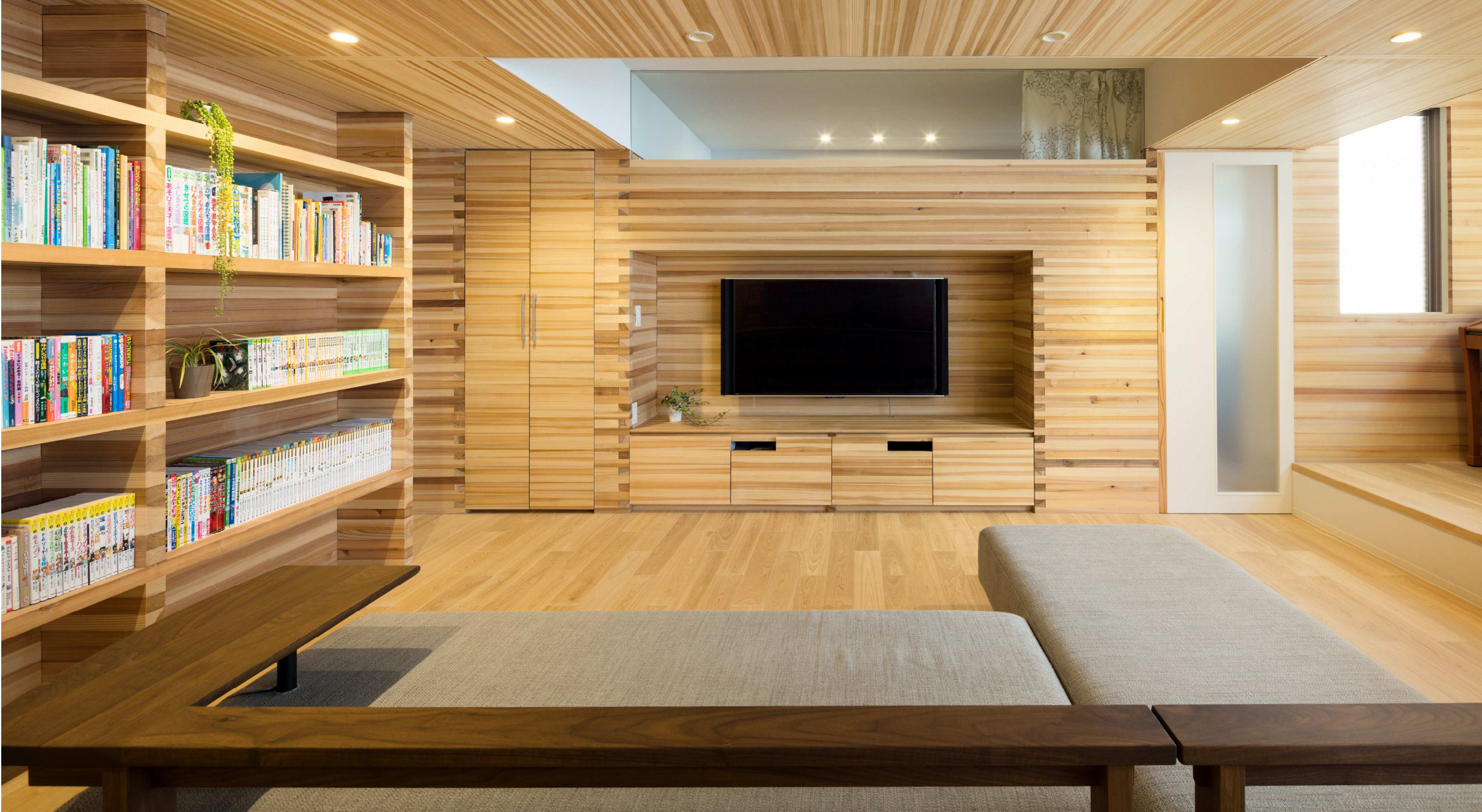
キッチンからリビングを見る。テレビ台まわりの壁、本棚は全て垂木材でできており(カウンターは巾ハギ材)、間仕切りも兼ねる大工による現場施工の造作。
