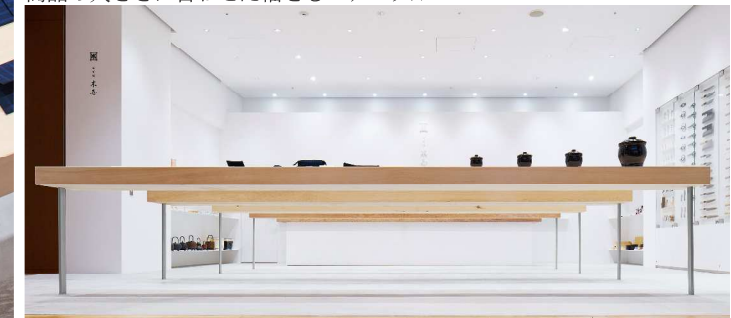
4.5m スパンに対して、120mm 厚の木材を架け渡した構造体
