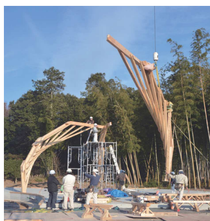
仕口(上)と組柱ユニットごとの施工風景(右)
