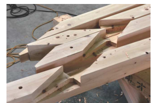
仕口(上)と組柱ユニットごとの施工風景(右)
