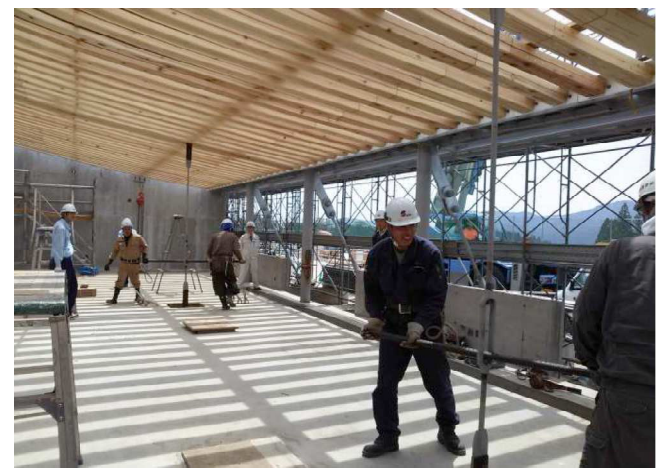
校舎棟木梁の張力導入の様子
