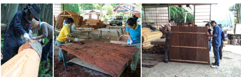
杉皮屋根パネル 杉皮剥ぎワークショップで杉皮を地元の山で調達
