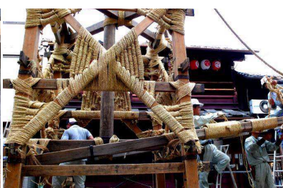
荒縄縛りによる接合 祇園祭の鉾にも使われる結び方「男結び」 大人がぶら下がっても大丈夫
