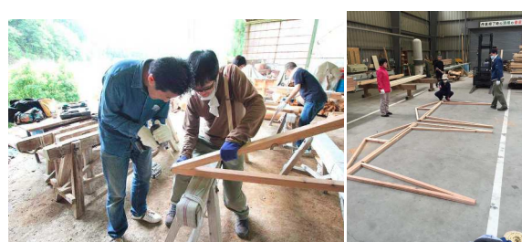
杉角材トラス どこにでもある材料で簡単に作る
