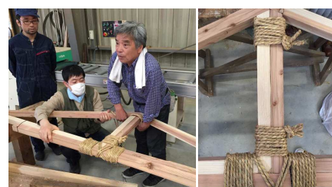
荒縄縛りによる接合 祇園祭の鉾にも使われる結び方「男結び」 大人がぶら下がっても大丈夫
