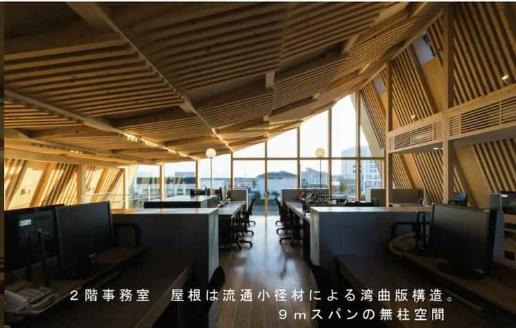
2階事務室 屋根は流通小径材による湾曲版構造。
