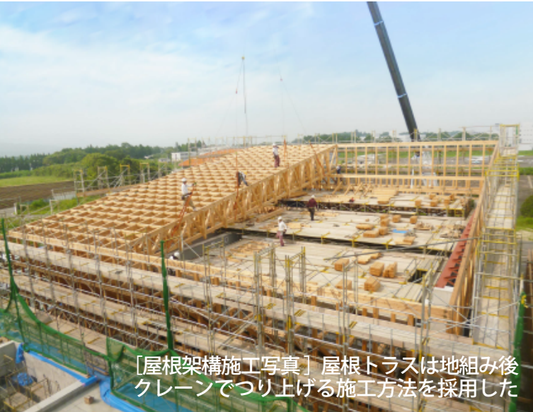
特殊な製作金物を使用せずに 20m スパンを実現させる トラスの斜材に発生する軸力は上下弦材方向に対しては欠き込みによる支圧、上下弦材直交方向に対してはボルトの引張耐力で抵抗する接合形式を採用した。910mm という細かなピッチでトラスをかけることで上記のディティールで臨める応力状態を成立させている。
