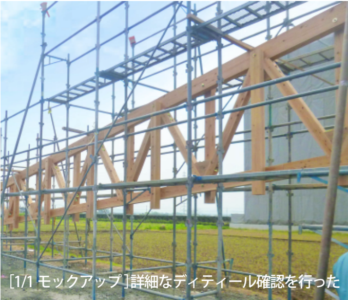
特殊な製作金物を使用せずに 20m スパンを実現させる トラスの斜材に発生する軸力は上下弦材方向に対しては欠き込みによる支圧、上下弦材直交方向に対してはボルトの引張耐力で抵抗する接合形式を採用した。910mm という細かなピッチでトラスをかけることで上記のディティールで臨める応力状態を成立させている。
