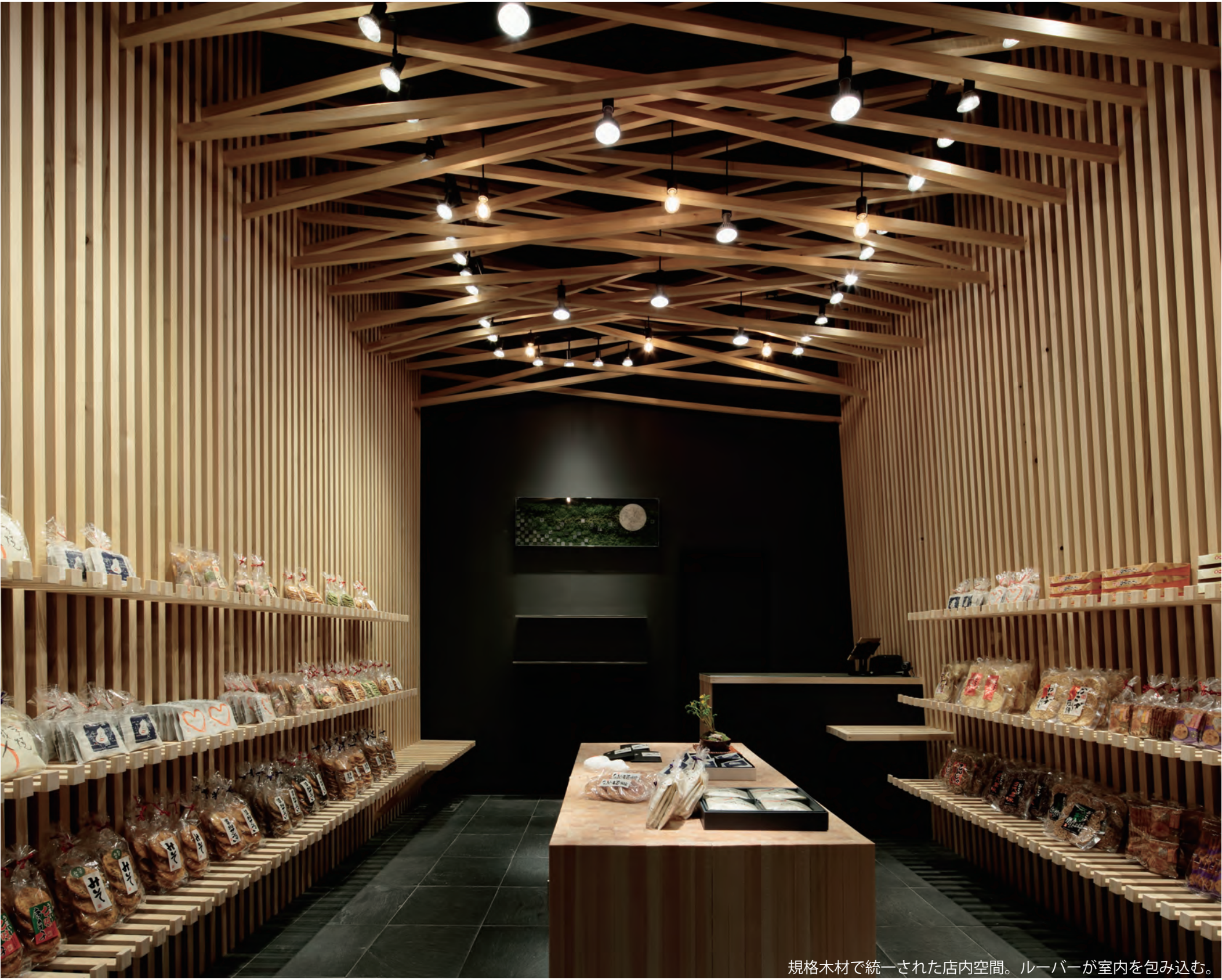
規格木材で統一された店内空間。ルーバーが室内を包み込む。
