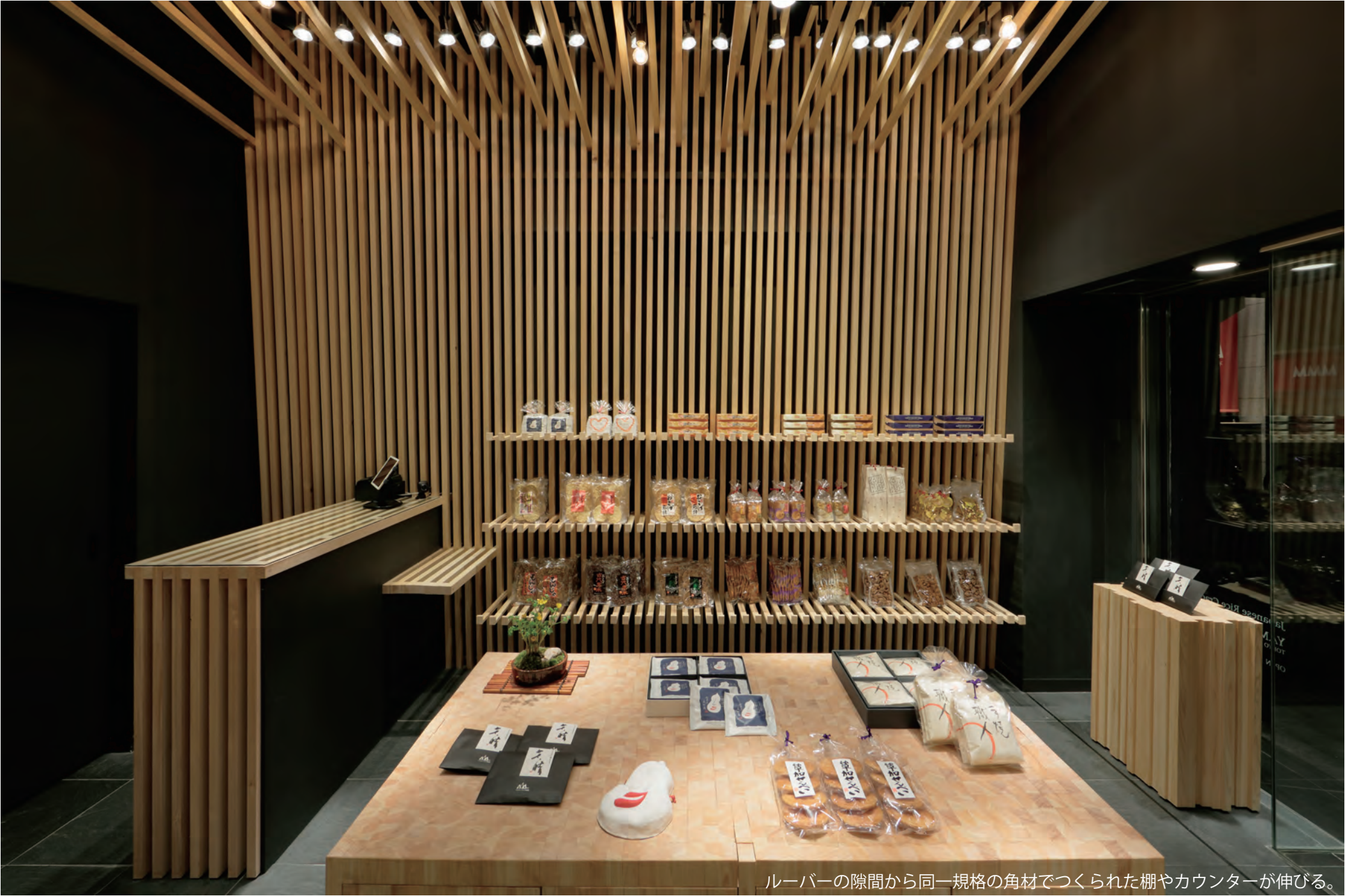
ルーバーの隙間から同一規格の角材でつくられた棚やカウンターが伸びる。
