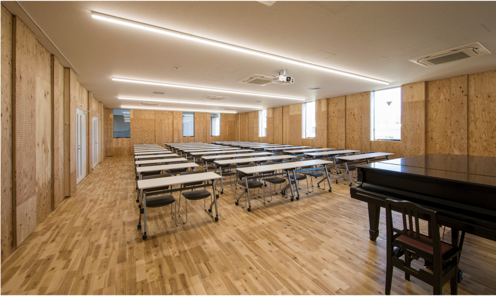
●講義室・レッスン室 壁の木板は有孔板と無孔板を組み合わせ音の響きを調整した
