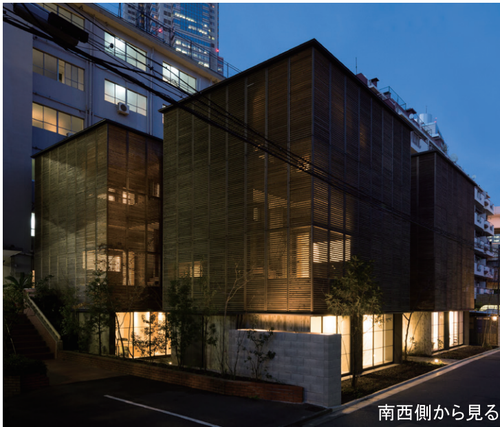
南西側から見る
