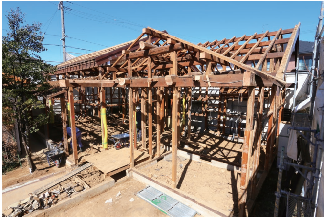
部分解体：一度スケルトンにし、部材の確認と寸法調査
