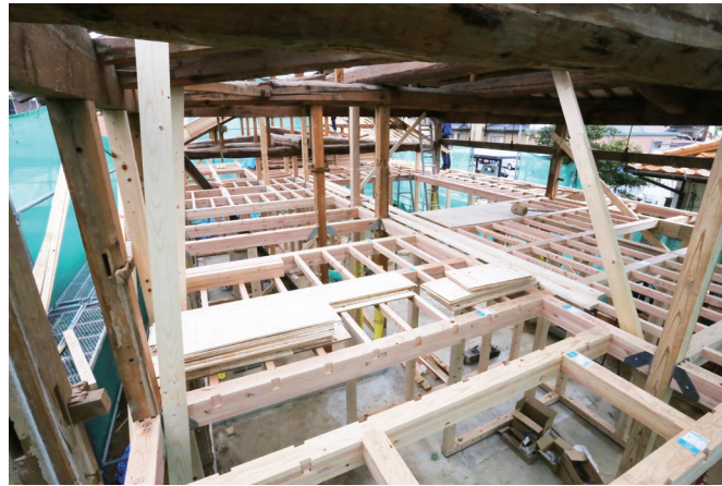
建方：旧構造材を補強するように、新材を挿入する
