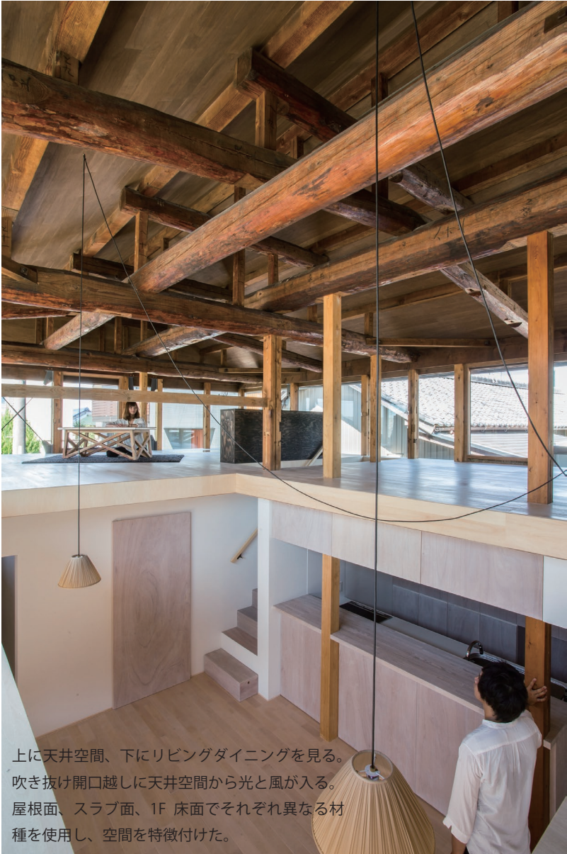
西側前面道路から見る。これまで隠れていた天井空間が表出し、町並みに奥行きをつくり出している。
