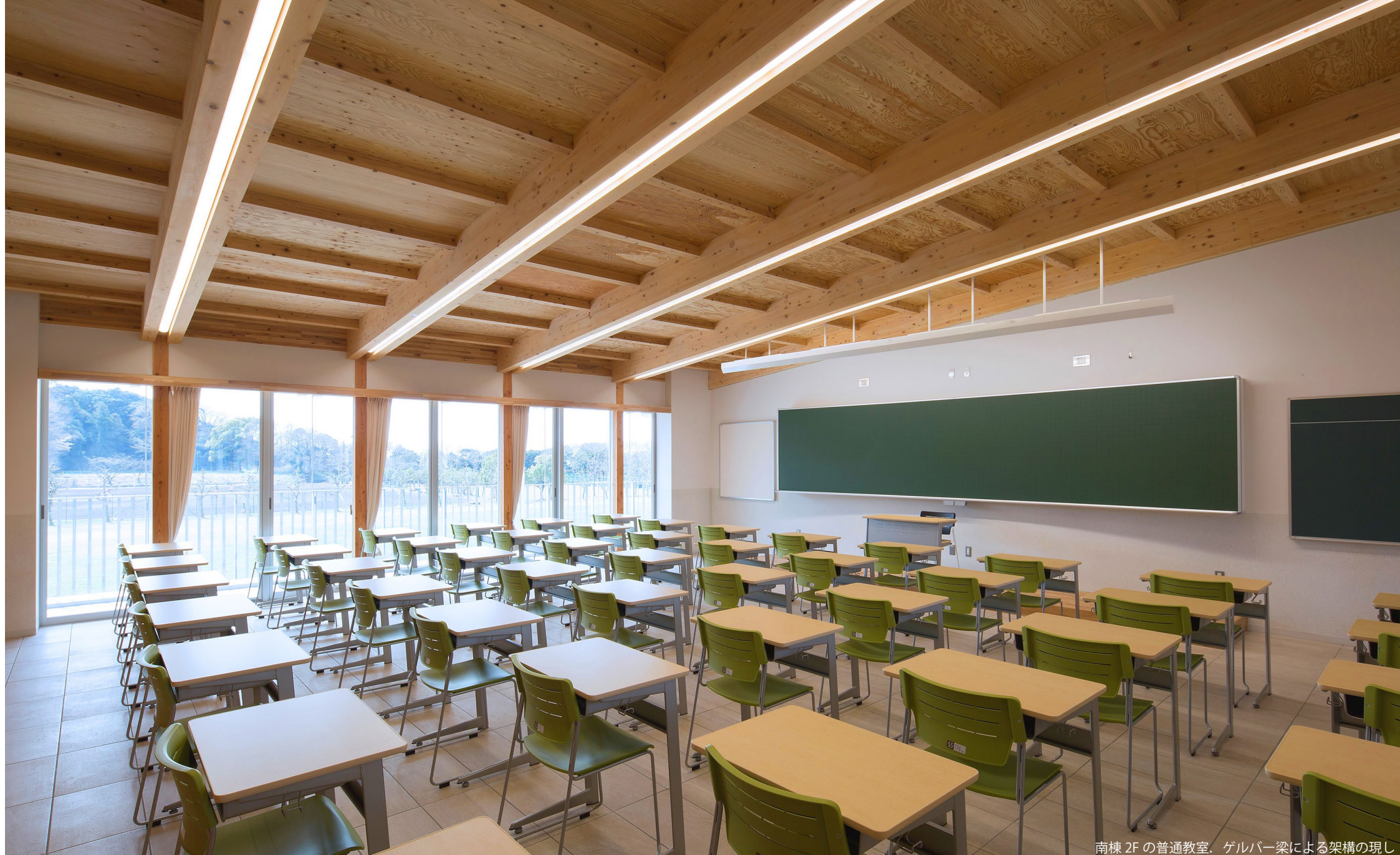
南棟 2F の普通教室、ゲルバー梁による架構の現し
