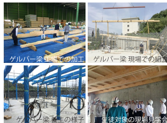
ゲルバー梁工場の様子
