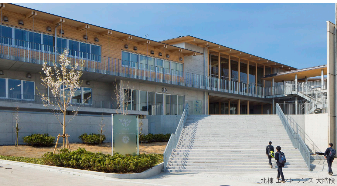
北棟 エントランス 大階段
